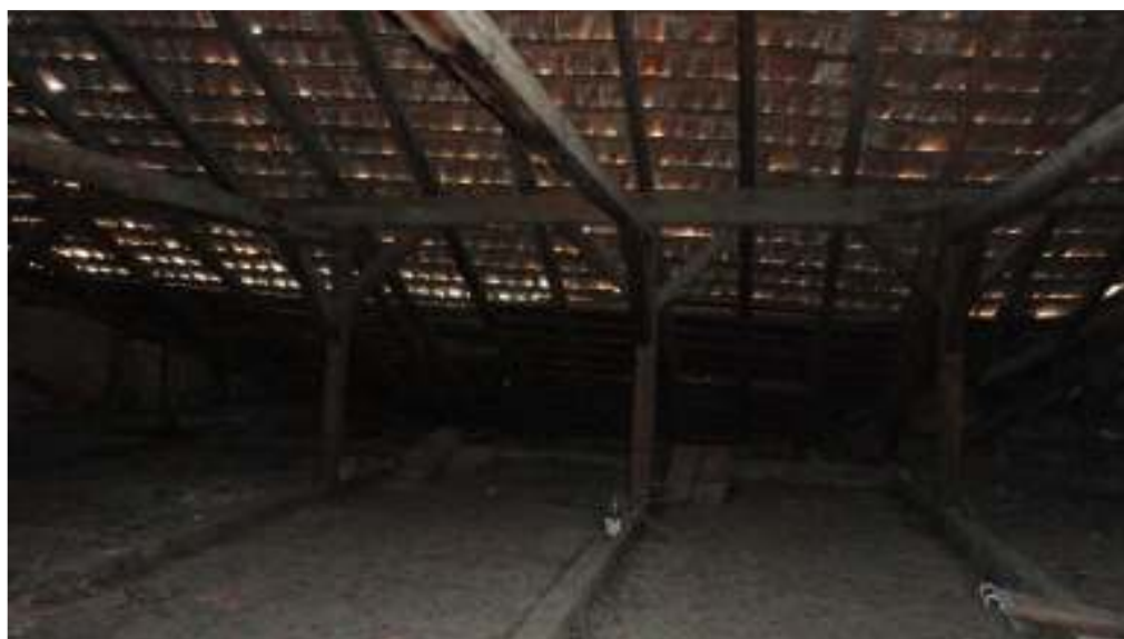
STRUCTURA SARPANTA CU INVELITORI TIGLE PROFILATE
