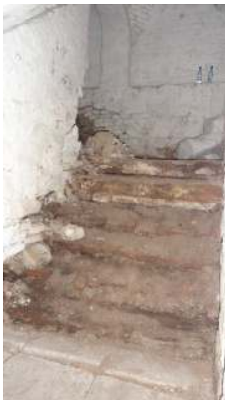
DEGRADAREA BIOLOGICA A TREPTELOR DIN LEMN
